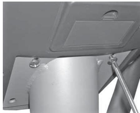
Collegare i fili provenienti dal tubo anteriore dal contatore. Premere i fili nel tubo anteriore e installare il contatore all'estremità del tubo anteriore. **IMPORTANTE!** Prestare attenzione a non danneggiare i fili! Fissare il contatore in posizione con quattro viti. Rimuovere la copertura protettiva dallo schermo e dalla tastiera del contatore.
